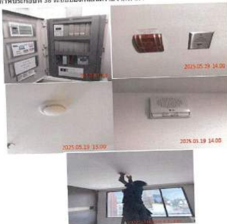
ภาพประกอบที่ 39 การทดสอบระบบแจ้งเตือน เหตุเพลิงไหม้ประจำสัปดาห์
