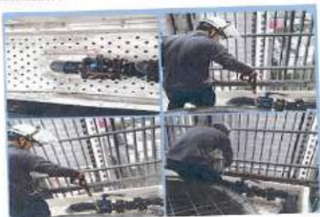
ภาพประกอบที่ 21 การทำความสะอาดถังเก็บน้ำสำรอง
